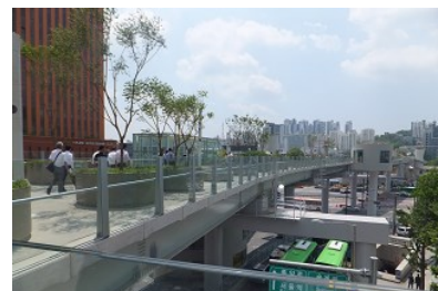
高速道路が歩道に変わった様子
